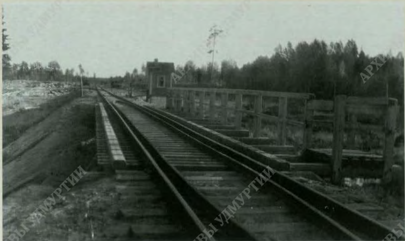
Деревянный мост на 35-м км северного подхода к ст. Меньил
