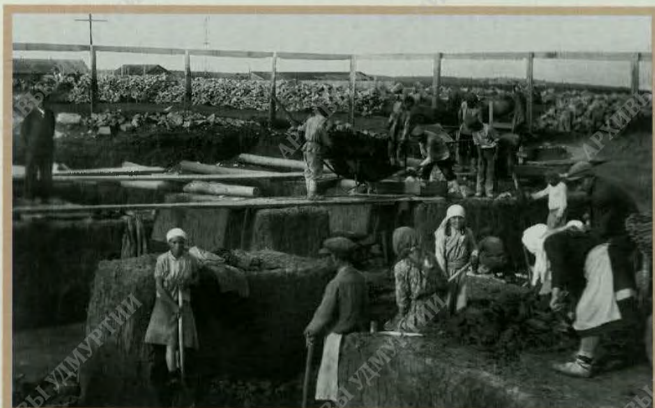
Рытье котлованов под фундаменты Ижевского вокзала. 1944 г.
