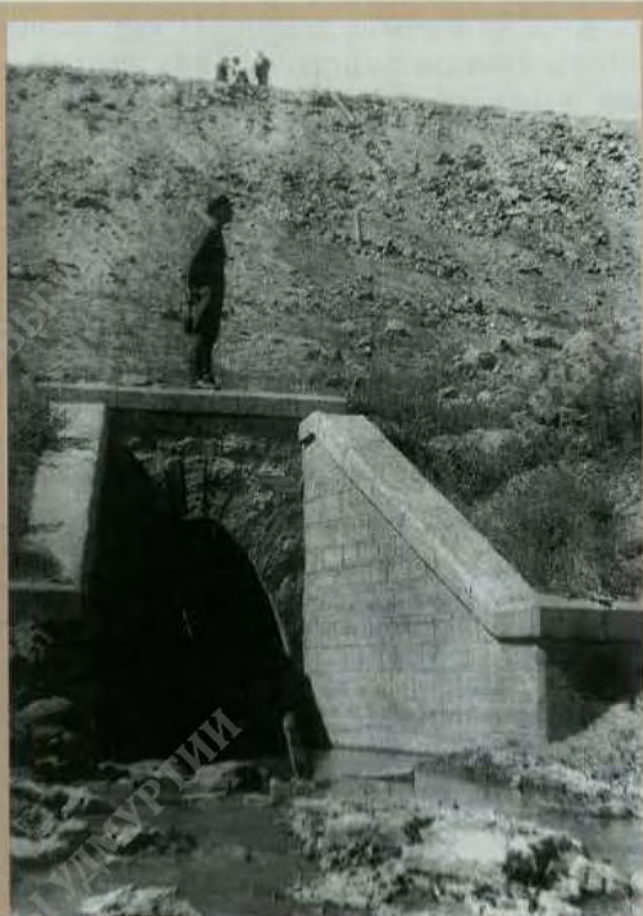
Каменная труба на 88-м км
