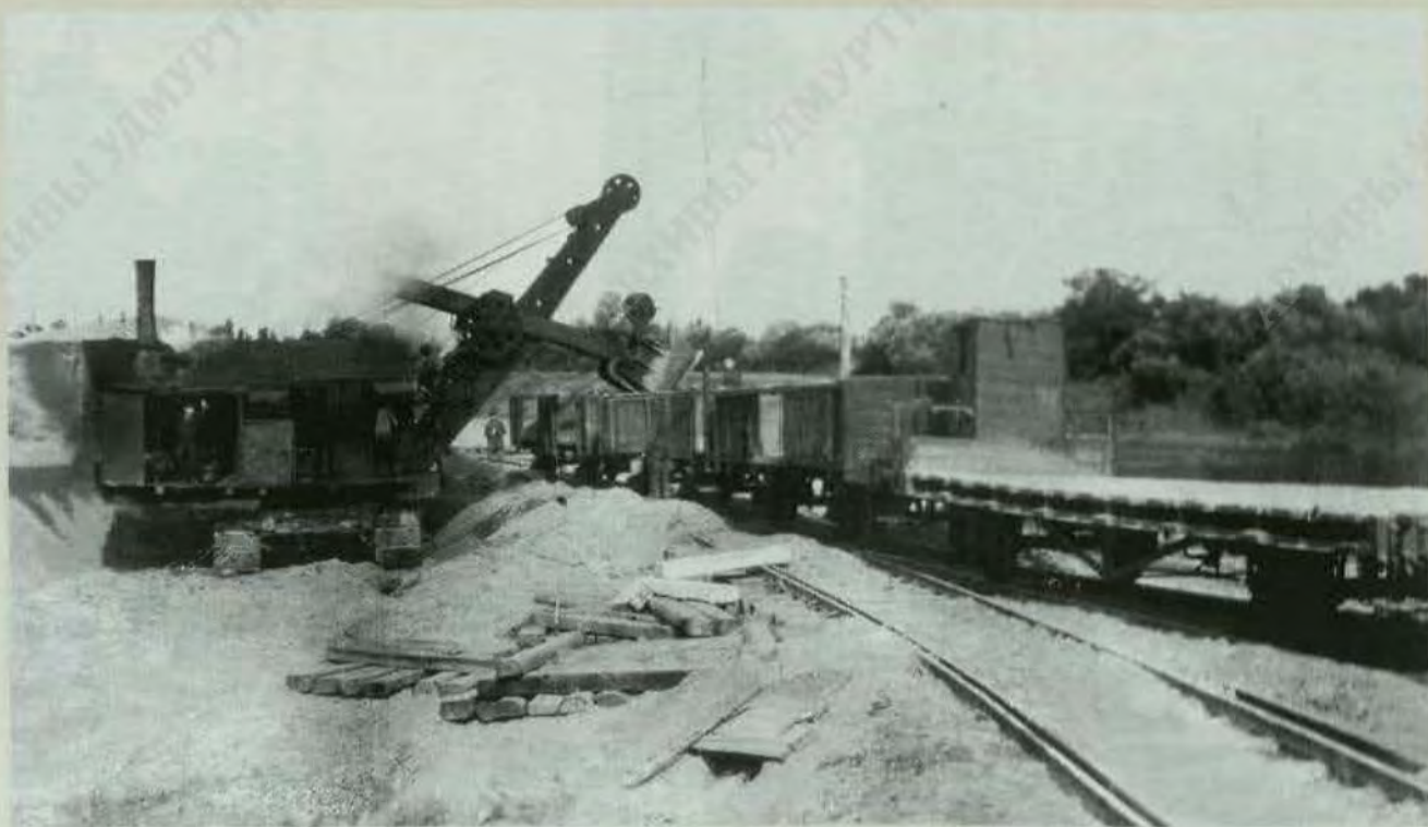
Погрузка балласта в Зилайском карьере
