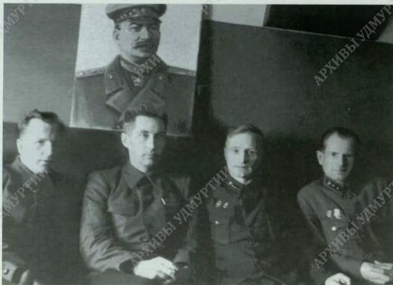
Руководители стройки: зам. секретаря Удмуртского обкома ВКП(б) по транспорту Г. П. Ольшанский (2-й слева), начальник Управления строительства № 31/38 В. Ф. Воробьев (3-й слева), г. Ижевск. 1945 г. (Фото из Национального музея УР)
