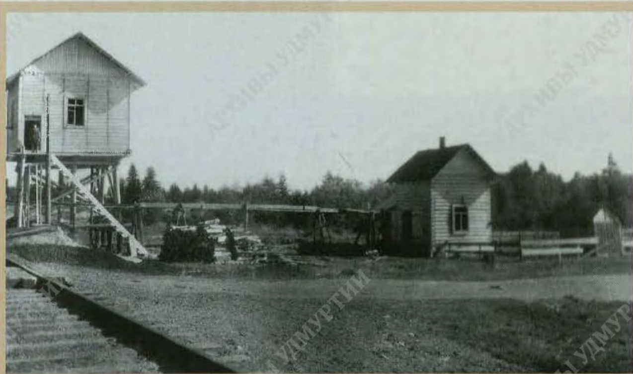
Пункт временного водоснабжения на 9-м км
