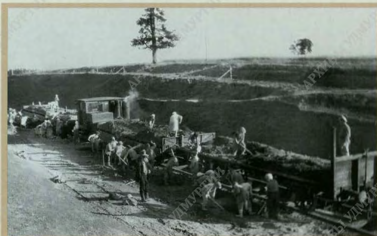
Заканчиваются работы на шарканской выемке Кекоранского хода. 1944 г.
