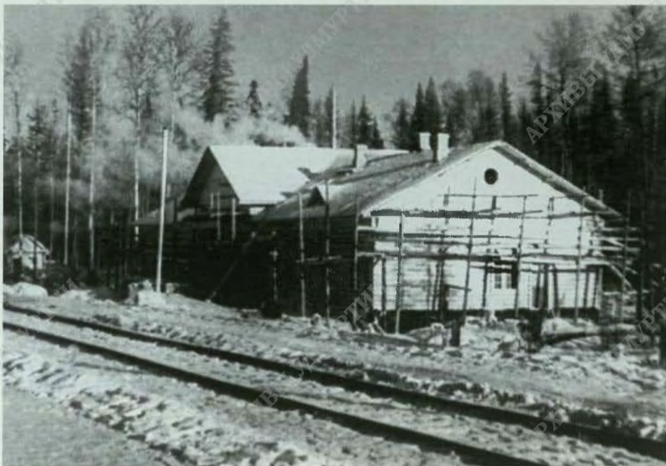
Строящееся здание пассажирского вокзала на ст. Игра
