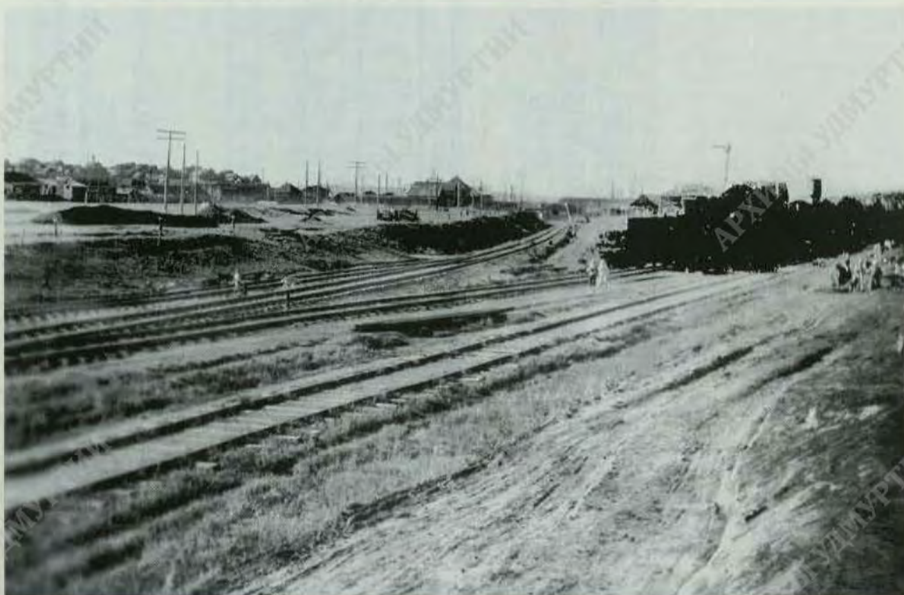
Место южного примыкания железной дороги Ижевск—Балезино к Казанской железной дороге на подходе к г. Ижевску, слева — путь новой линии
