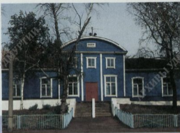
Железнодорожный вокзал в г. Камбарке. 2000 г. Фото Р. М. Мирзянова
