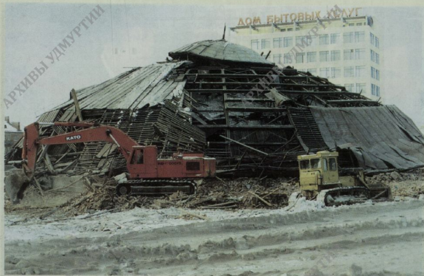
Разборка здания старого цирка г. Ижевска. 1999 г.
