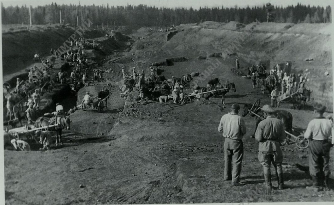
На строительстве железной дороги Ижевск—Балезино. 1942 г.
