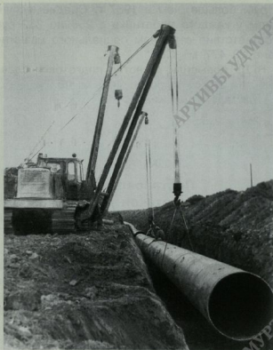
Укладка труб на удмуртском участке газопровода «Уренгой-Ужгород». Октябрь 1982 г.
