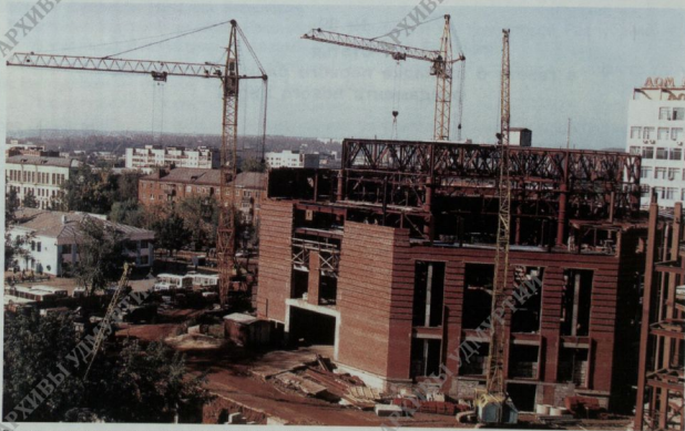
Строительство нового цирка в г. Ижевске. 2002 г.
