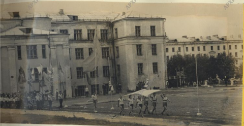
Открытие стадиона, посвященного Шоляшиков
