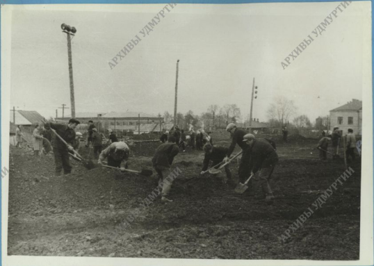
Учащиеся техникума на строительстве стадиона „ Энергия “.
