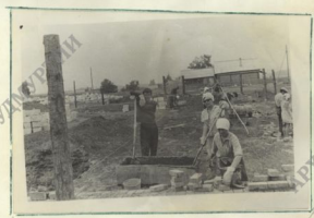
Время идет, стройка растет.
