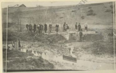
На строительстве плотины.
