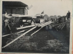
Старое место за разружкой строительного мате- риала на дровянике.
