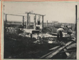
Строительная дружба. Встретили отечник и здание под электростанцию.
